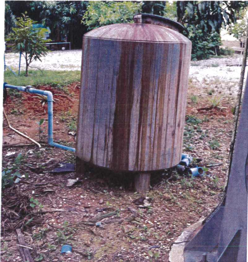
ถังกรองเหล็กระบบประปา บ้านหน้าสถานีรถไฟคลองไทร ม. 1
